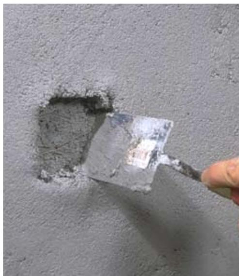
После завершения проверки снова нанесите Densit® WearFlex на поверхность и разгладьте с помощью строительной панели.
